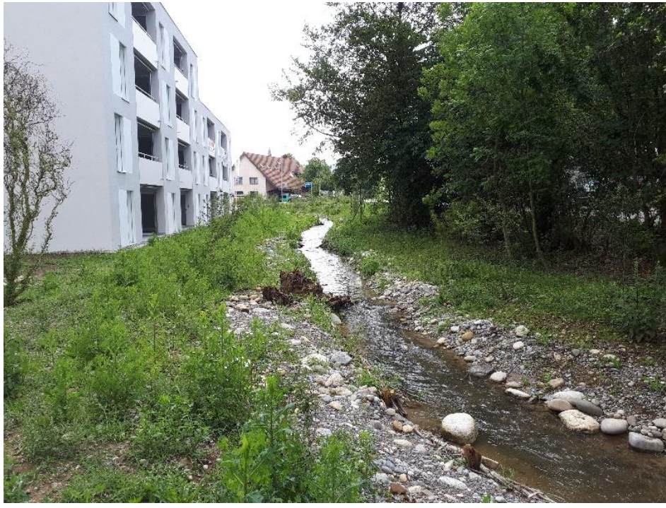
Abbildung 26 Beispielhafte Gerinneführung mit kontrolliertem Abflussvolumen
